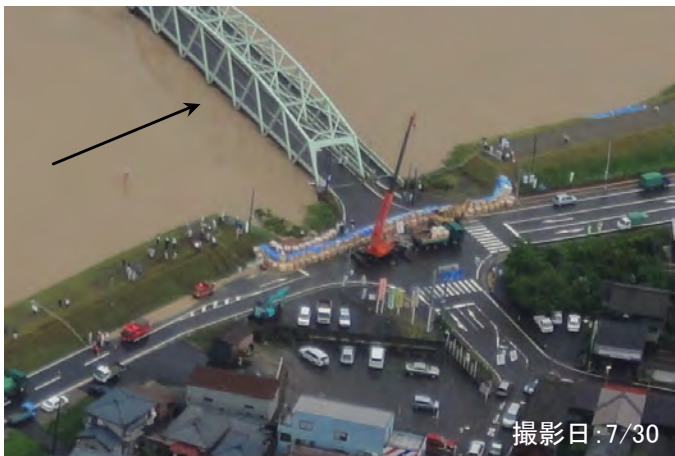
ヘリからの作業状況
