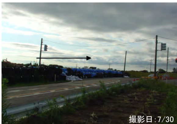
臼井橋右岸交差点の状況
