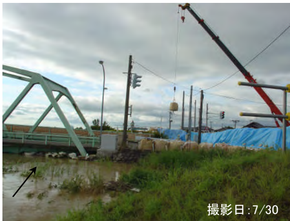
河川水位が上昇したため補強対策を実施
